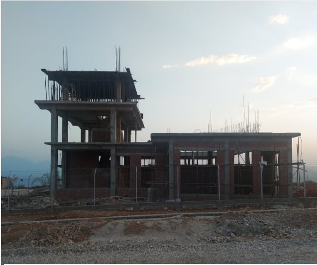
रेसुङ्गा विमानस्थलको निर्माणाधीन कन्ट्रोल टावर
